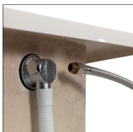
7. Retirez le bouchon d'obturation de l'entrée et fixez le tuyau flexible à la connexion d'entrée assemblée.
