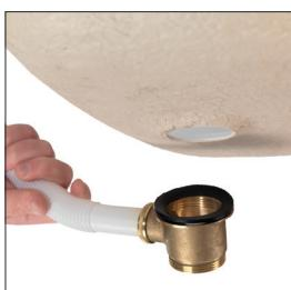
3. Remettez en place la bonde de vidage pour baignoire en veillant à ce que la rondelle en caoutchouc soit correctement alignée entre le bloc de la bonde de vidage et la base de la baignoire.
