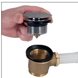
2. Dévissez et retirez avec précaution le bloc clic clac de la bonde de vidage pour baignoire du corps de la bonde vidage et mettez-le de côté.
