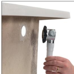
5. Positionnez le bloc du corps de sortie à l'arrière de la baignoire en veillant à ce que la rondelle en caoutchouc soit correctement alignée entre le bloc du corps de sortie et la paroi de la baignoire.
