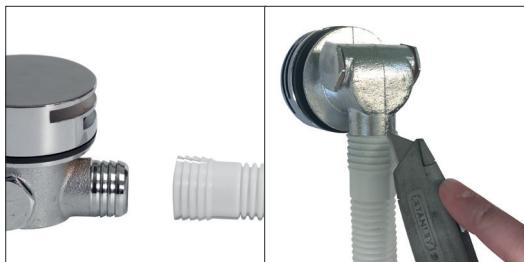
4. Zum erneuten Zusammenbau schieben Sie das längere Abflussrohr über den Auslass und befestigen es mit einer Schlauchschelle (nicht im Lieferumfang enthalten). Bauen Sie die Abflussgarnitur anschließend wieder ein.
