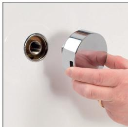
2. Zorg ervoor dat de rubberen ring correct is uitgelijnd, voer de uitloop van de overloopvuller door het bad en bevestig deze aan de eenheid.
