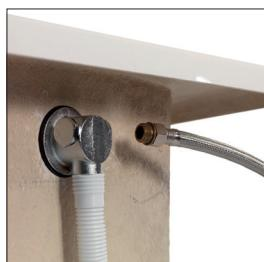
4. Podłącz elastyczny wąż do mieszanej rury zasilającej, upewniając się, że zamontowano odpowiedni, nieograniczający podwójny zawór zwrotny (brak w zestawie), zgodnie z obowiązującymi przepisami dotyczącymi zaopatrzenia w wodę.
