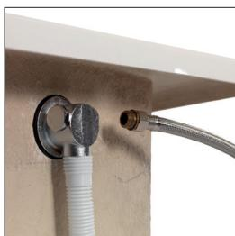
3. Entfernen Sie den entsprechenden Einlassstopfen und schließen Sie den flexiblen Schlauch an den Anschluss des Mischwassereinlasses an.
