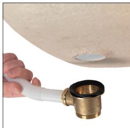
3. Monteer de badafvoer op zijn plaats en zorg ervoor dat de rubberen ring correct is uitgelijnd tussen de afvoer en de badbodem.
