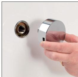
6. En veillant à ce que la rondelle en caoutchouc soit correctement alignée, faites passer la sortie du remplissage par trop-plein à travers la baignoire et fixez-la aux bloc du corps.
