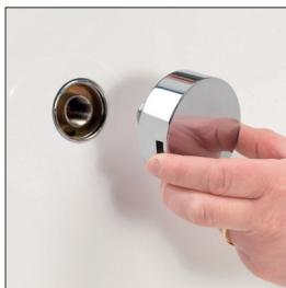
2. Vergewissern Sie sich, dass die Gummi-Einlegscheibe richtig ausgerichtet ist, führen Sie den Auslass der Überlaufgarnitur durch die Wanne und befestigen Sie ihn am Körper der Garnitur.
