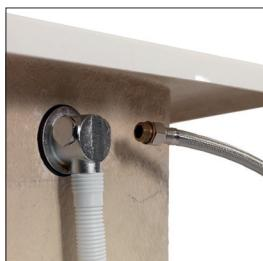
3. Verwijder de betreffende inlaatafdichtplug en sluit de flexibele slang aan op de gemengde inlaataansluiting.
